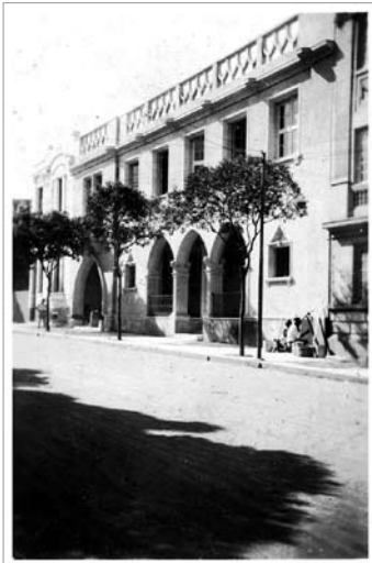
Fachada da Igreja - Paróquia Martin Luther - 1928
