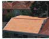
Telhado novo sobre a sede do Boverê
