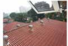
Telhado reformado da Igreja
