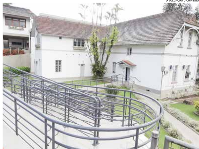
A rampa liga a igreja e o estacionamento ao prédio administrativo
