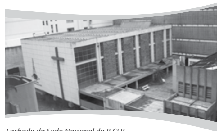
Fachada da Sede Nacional da IECLB (antes da revitalização)
