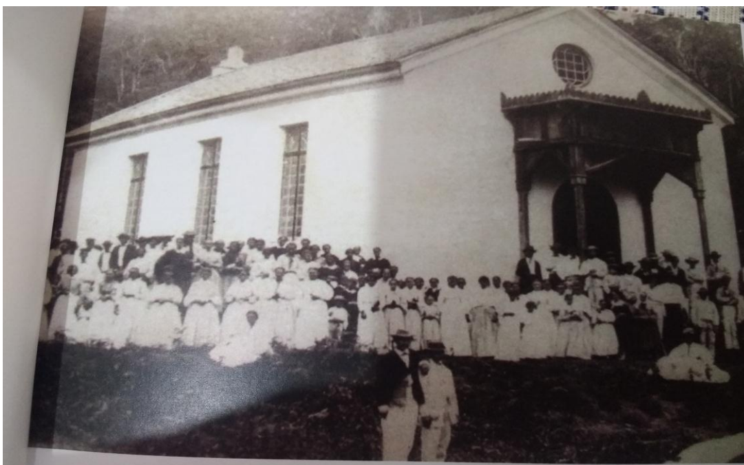
Anexo 2: Foto da primeira capela construída pelos imigrantes em Domingos Martins.
