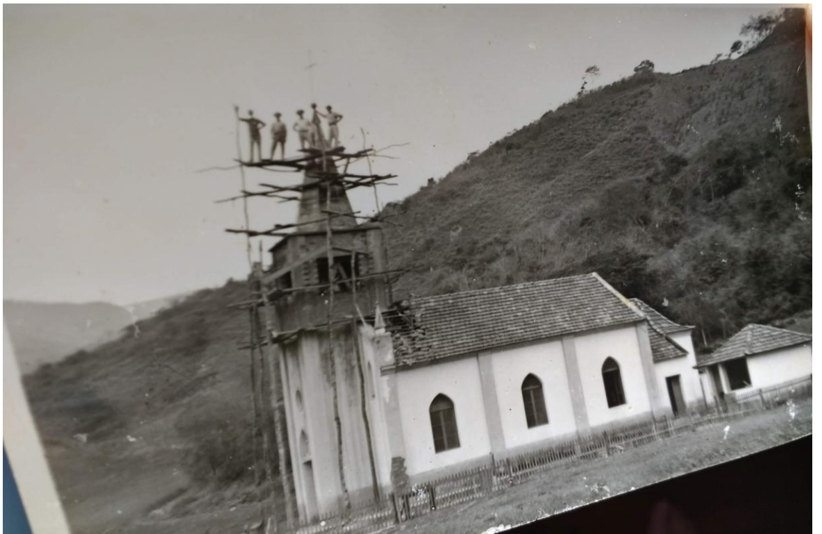
Anexo 6: Registro da construção da torre da comunidade de Ribeirão do Costa.
